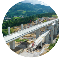
Y Basque Viaductos Zabaleta © Adif
