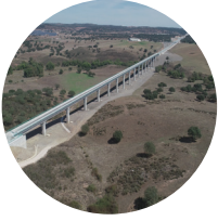
Madrid Lisbon (PT) Viaduto do Lucefere © Infraestruturas de Portugal
