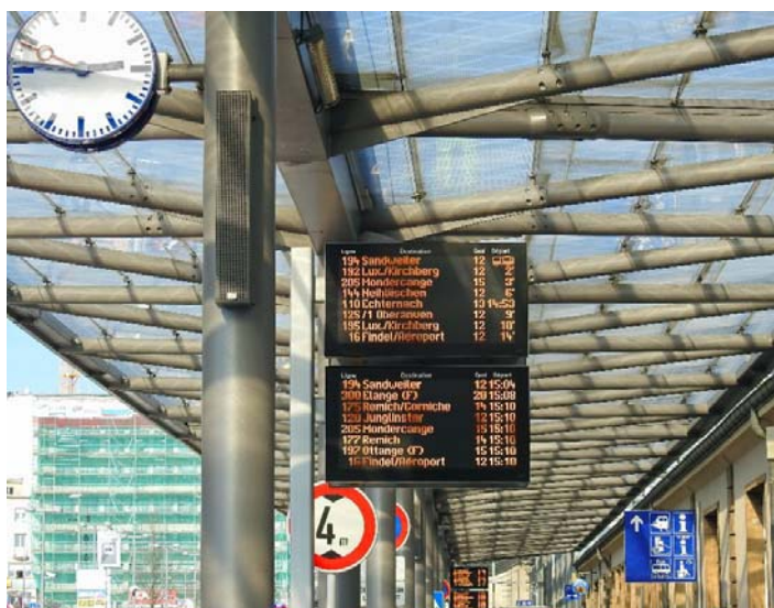
Affichage dynamique (FIA) des horaires de bus à la Gare Centrale de Luxembourg ville
