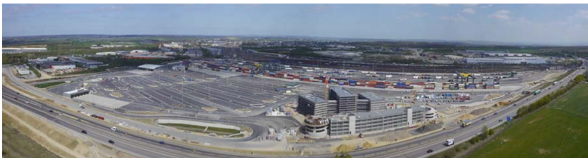
nouvelle plateforme multimodale de Bettembourg-Dudelange, CFL multimodal
