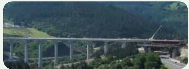
Viaduct over River Deba. Bergara (July 2015) http://www.euskalyvasca.com/es/co_quees_faqs.html
